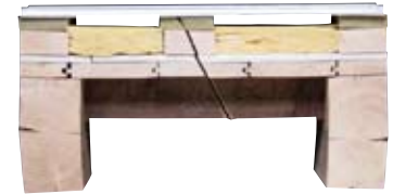
Sichtbare Balkenkonstruktion
